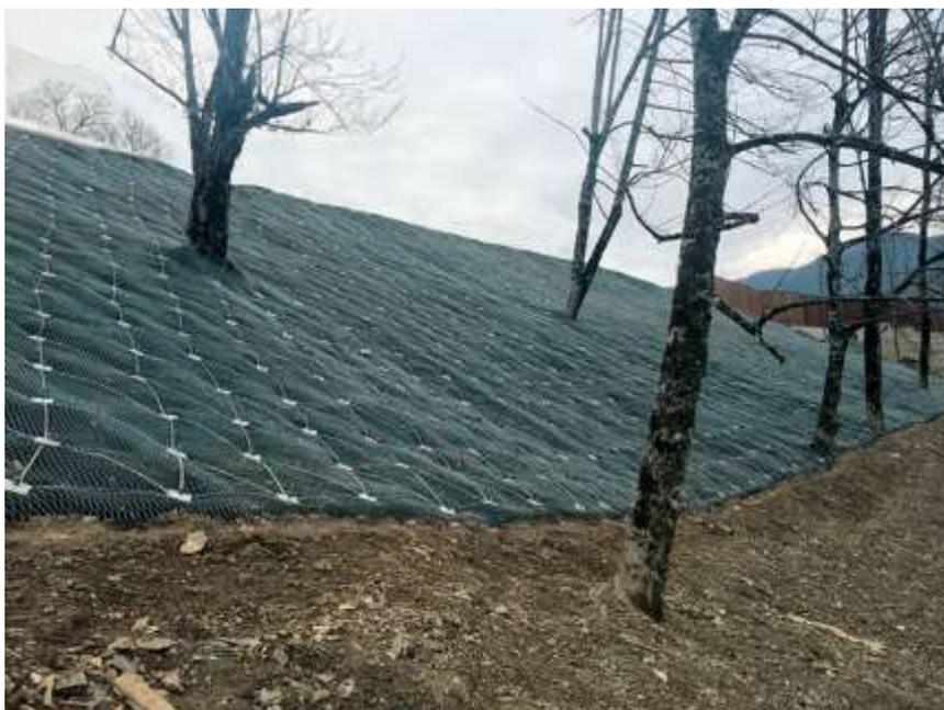
Рисунок 3 - Крепление оползневых склонов анкерными технологиями
