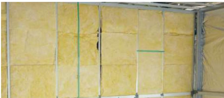
Рисунок 4— Пустоты в профилях каркаса не заполнены ватой
