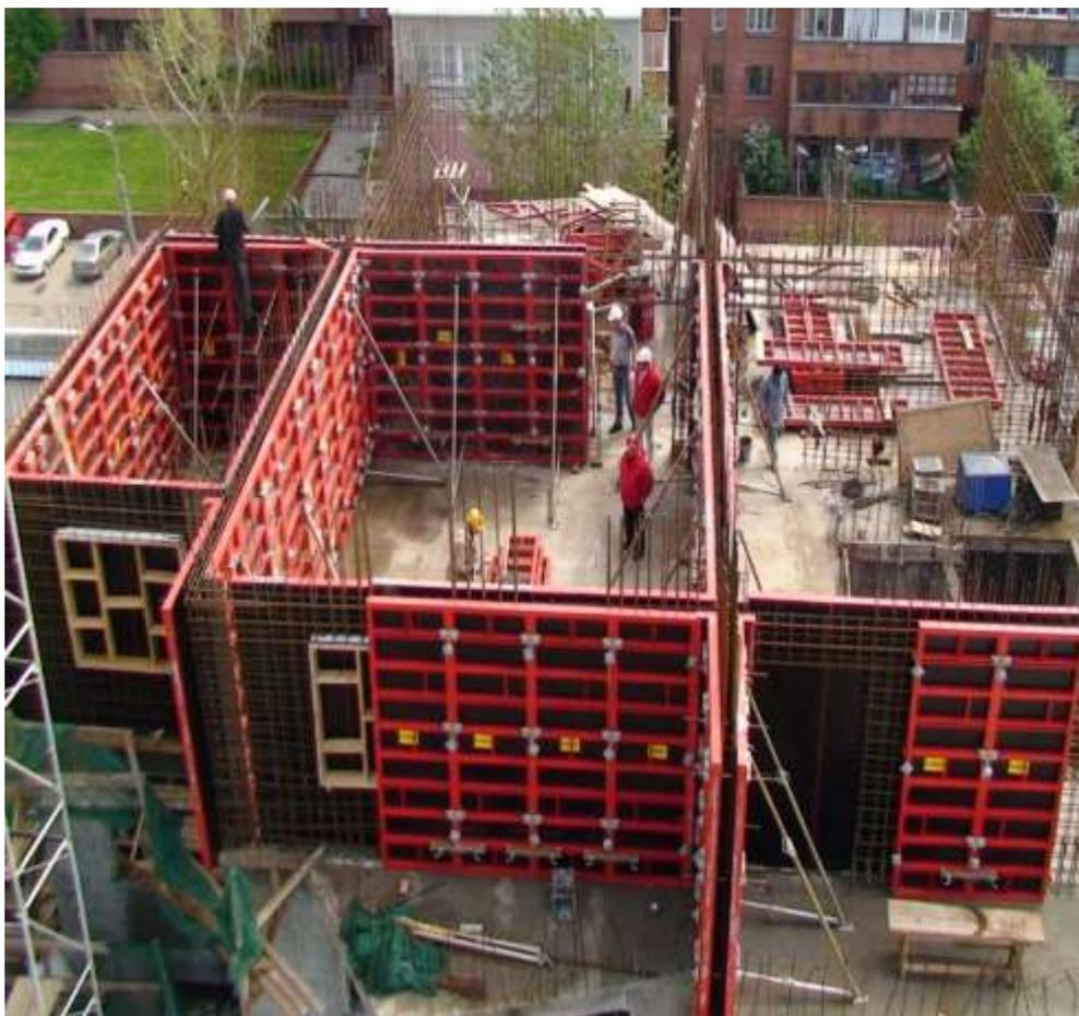
Рисунок 2 - Установка опалубки монолитного дома
