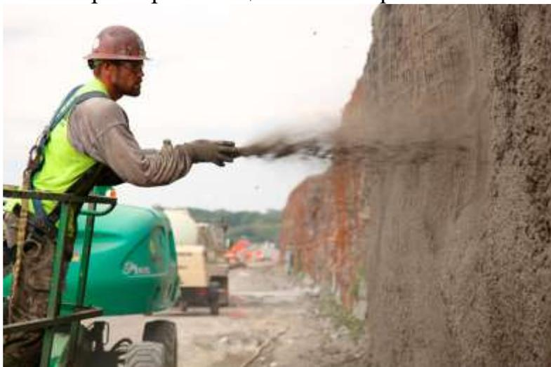
Рисунок 2 - Покрытие оползневых склонов торкретбетоном
