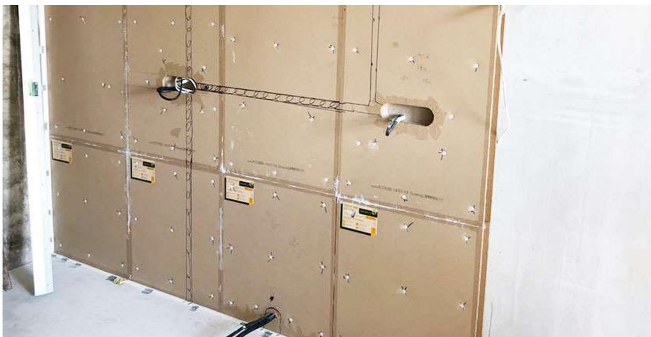
Рисунок 2 - Монтаж песочных панелей
