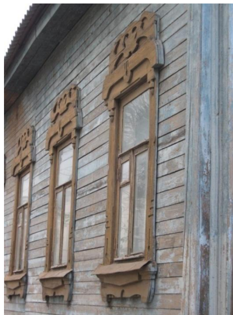
Фото 10. фрагмент фасада с наличниками. Современное состояние.
