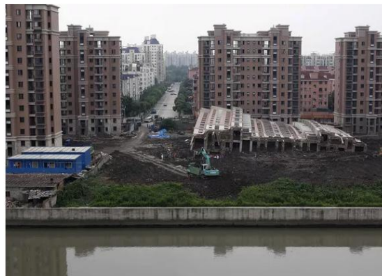
Рисунок 2 – Многоэтажное здание, упавшее в Шанхае
