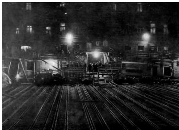
Рисунок 1 - Перемещение по парным рандбалкам
