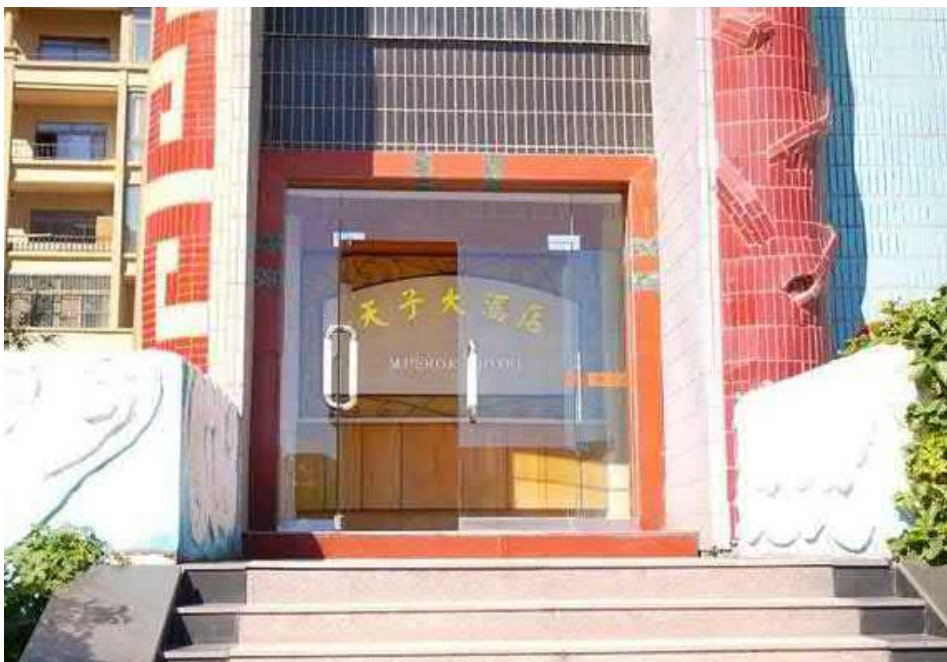
Рисунок 4 - Вход в здание расположен в нижней части правой ноги бога Шоу
