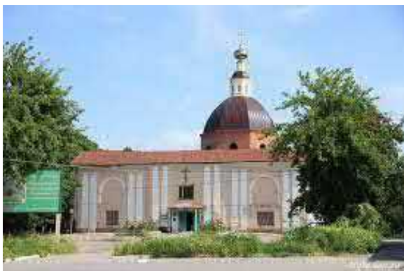
Рисунок 3 – Староямская Никольская церковь. Ул. Николодворянская, д. 12
