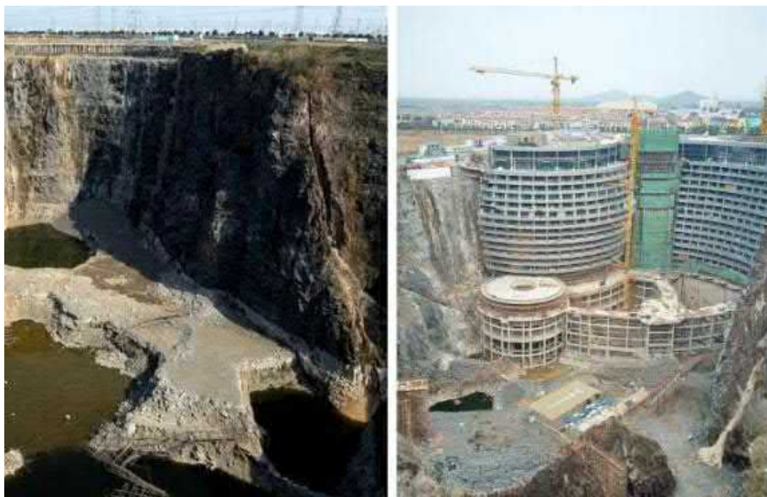
Рисунок 3 - Заброшенный карьер стал строительной площадкой для подземного отеля (Songjiang InterContinental)
