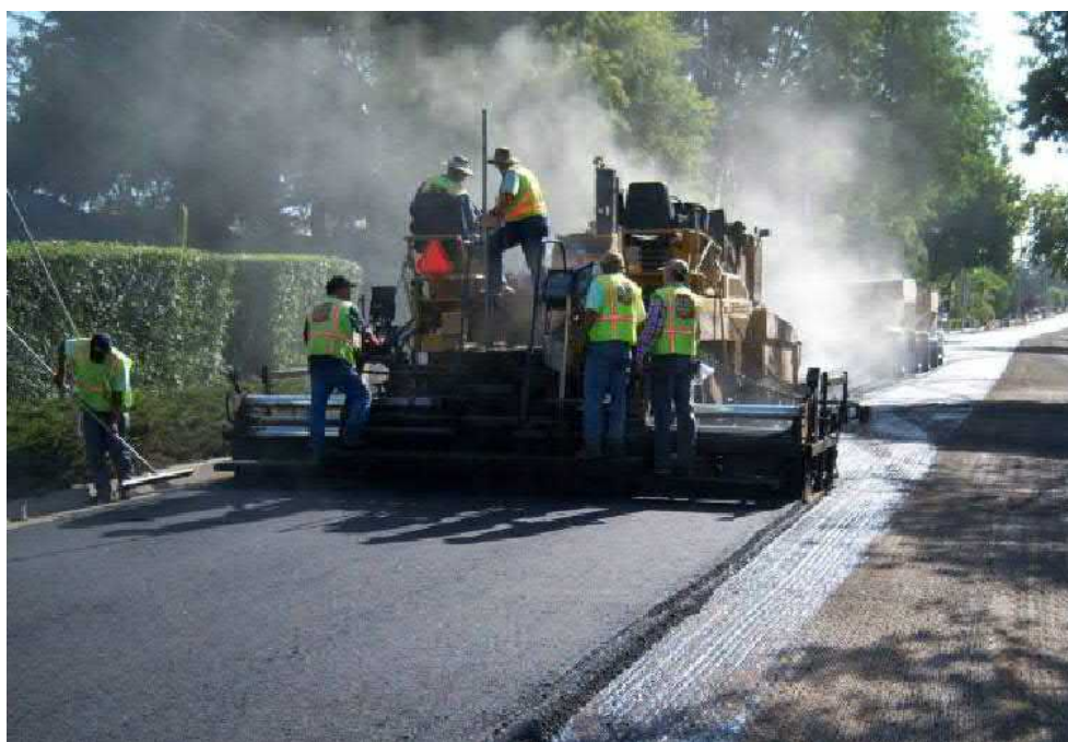
Рисунок 2 – Укладка асфальтового полотна дорожно-строительной машиной
