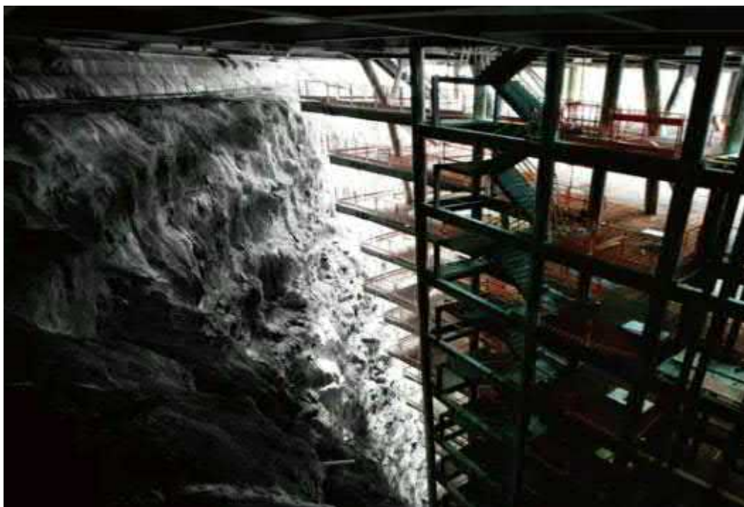
Рисунок 5- Отель в стадии строительства
