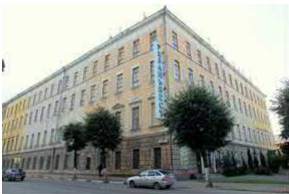
Рисунок 1 – Здание Рязанских присутственных мест. Соборная площадь, д. 21
