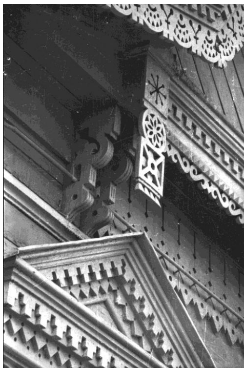
Фото 9. Деталь фронтона дома 19 по Первомайскому проспекту
