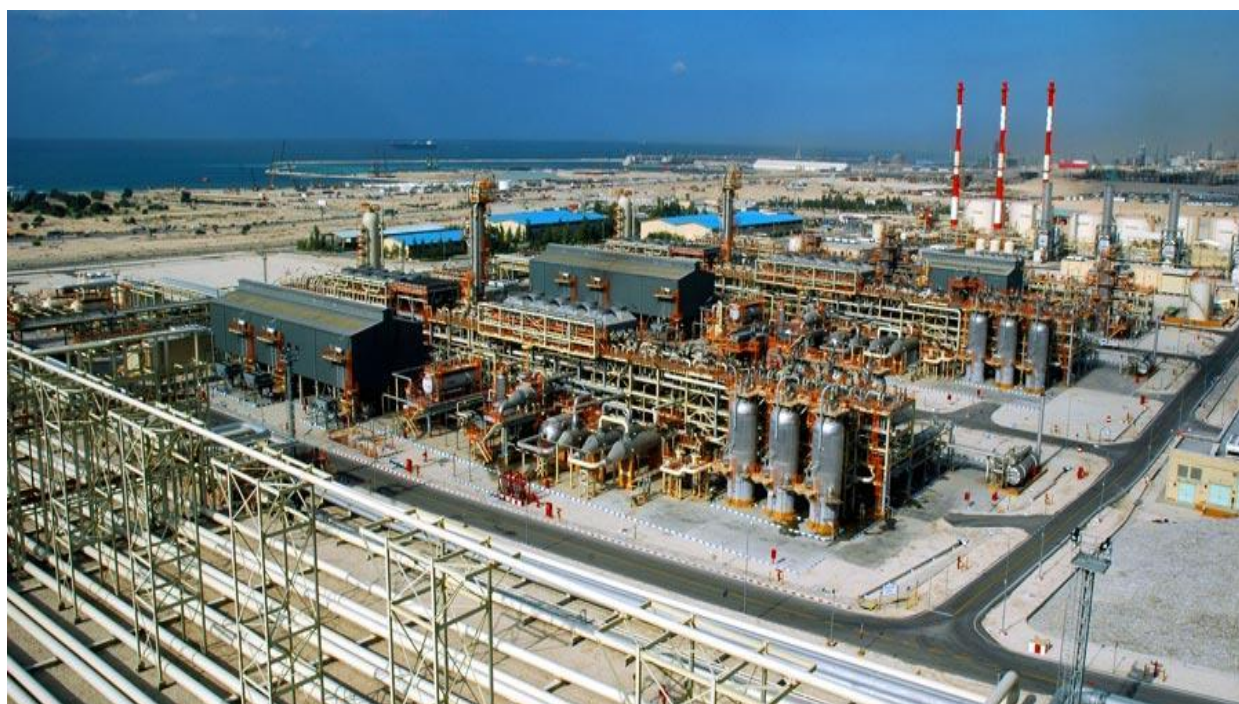
Рис.2. Очистительный газовый завод(фаз 2,3) в регионе Южный Парс [14].
