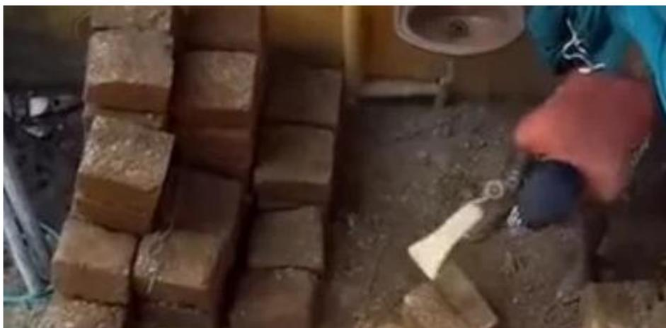
Рисунок 3 - Разнорабочий вытачивает блоки щербком
