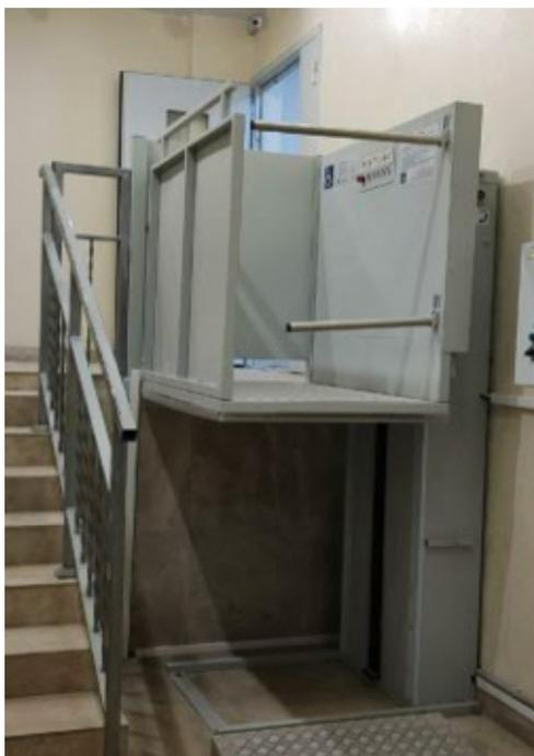
Рисунок 4 - Подъемник для МГН
