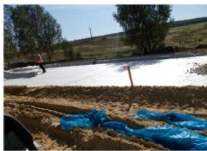
Рисунок 2 - Устройство прослойки из геотекстиля
