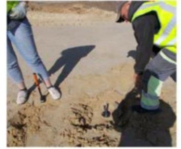
Контролем плотности естественного основания (рис. 1) является метод отбора образцов с последующим лабораторным определением требуемых показателей по ГОСТу 22733–2002. Допускается использовать экспресс-методы и приборы для ускоренного контроля плотности (пенетрационные, штамповые, прибор Ковалева и др.).
