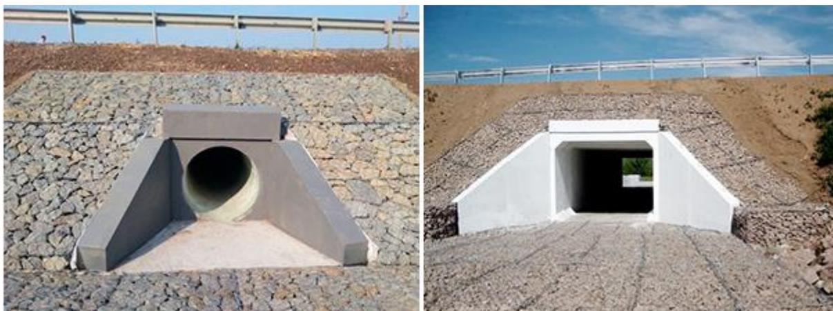
Рисунок 3 - Железобетонные трубы с отверстиями прямоугольного и круглого очертания
