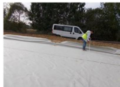
Рисунок 3 - Приемочный контроль устройства прослойки из геотекстиля
