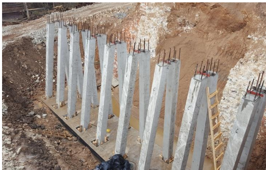
Рисунок1 – Погружение свай р.Павловка ОП1
