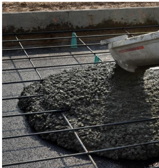
Рисунок 7 - Устройство выравнивающего слоя перед изоляцией
