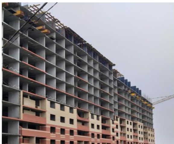
Рисунок 1 – Общий вид возводимых ограждающих конструкций
