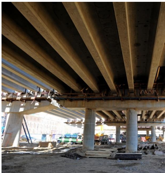
Рисунок 6 - Омоноличивание и гидроизоляция снизу
