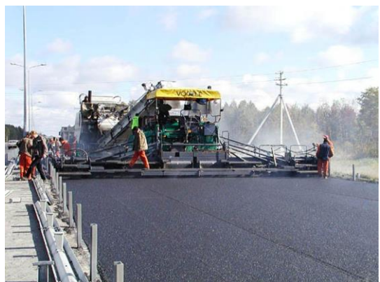
Рисунок 9 - Устройство верхнего слоя покрытия на мосту
