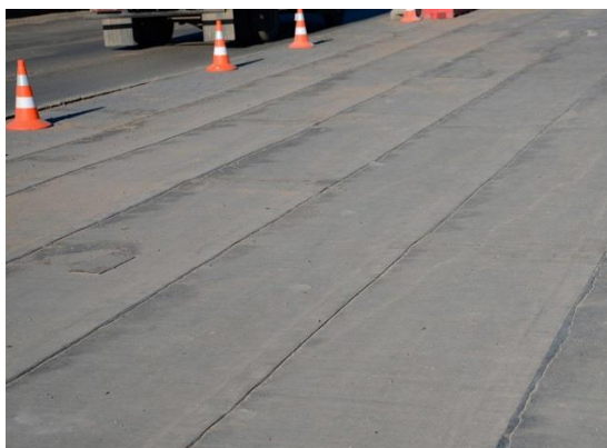
Рисунок 8 - Изоляция перед устройством асфальтобетонного покрытия
