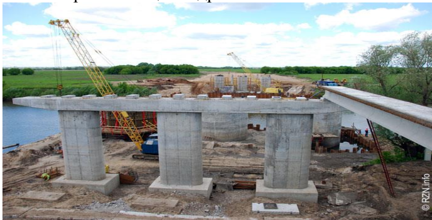
Рисунок 2 – Монолитные подферменники ОП4 установка пролетов
