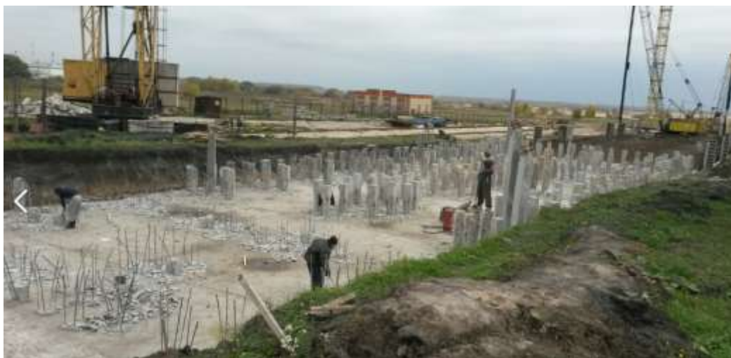
Рисунок 3 – Срубка голов свай
