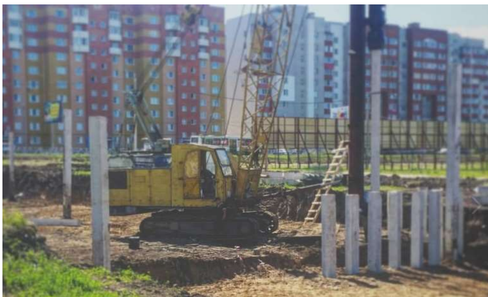
Рисунок 1 – Забивка свай универсальным сваебойным агрегатом
