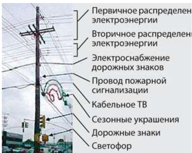
Рисунок 1 - Различные конструкции опор воздушных линий
