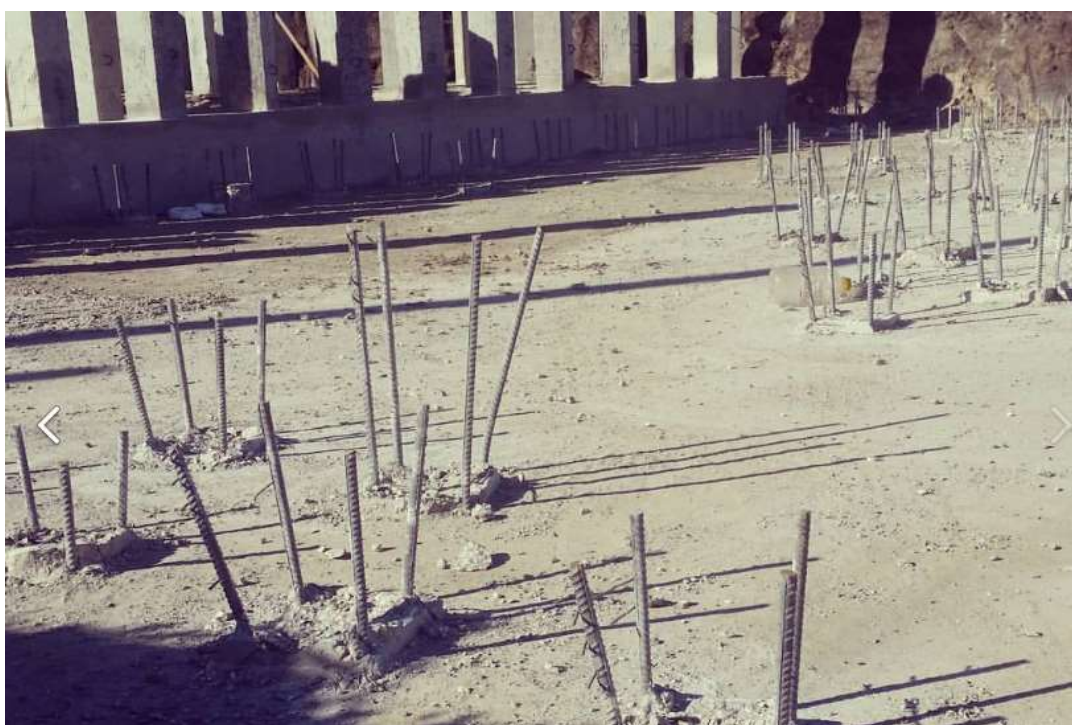
Рисунок 4 – Выпуски арматуры из свай
