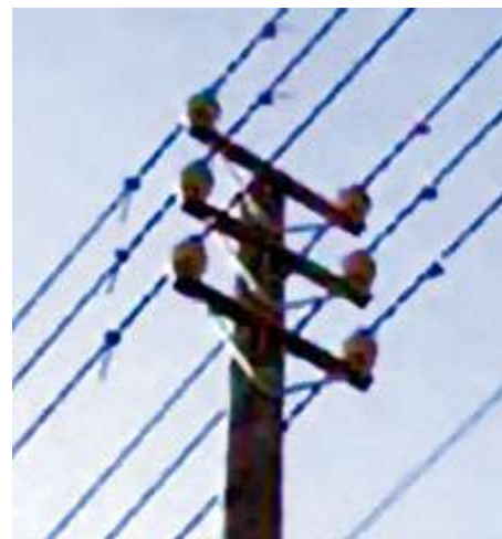
Рисунок 3 - Деревянная опора ВЛ с СИП напряжением 20 кВ (Финляндия)
