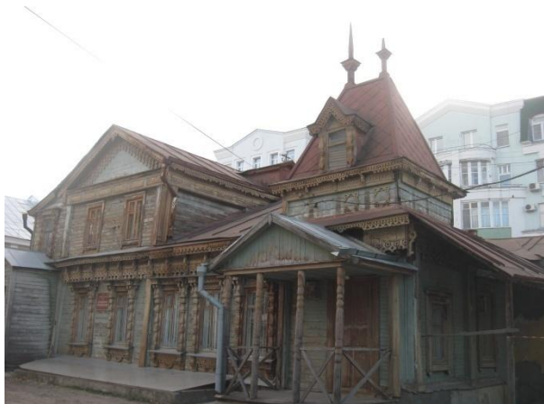
Рисунок 9 - Дом № 13А на ул. Полонского. Современное фото
