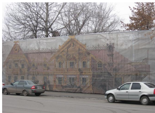
Рисунок 2 - На фото уже сгоревший дом затянут фальш-фасадом.
