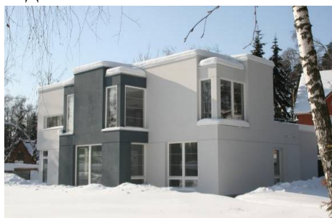
Рисунок 5 - Активный дом, построенный в Западной долине (Московская область, Южное Бутово), 2011 г.
