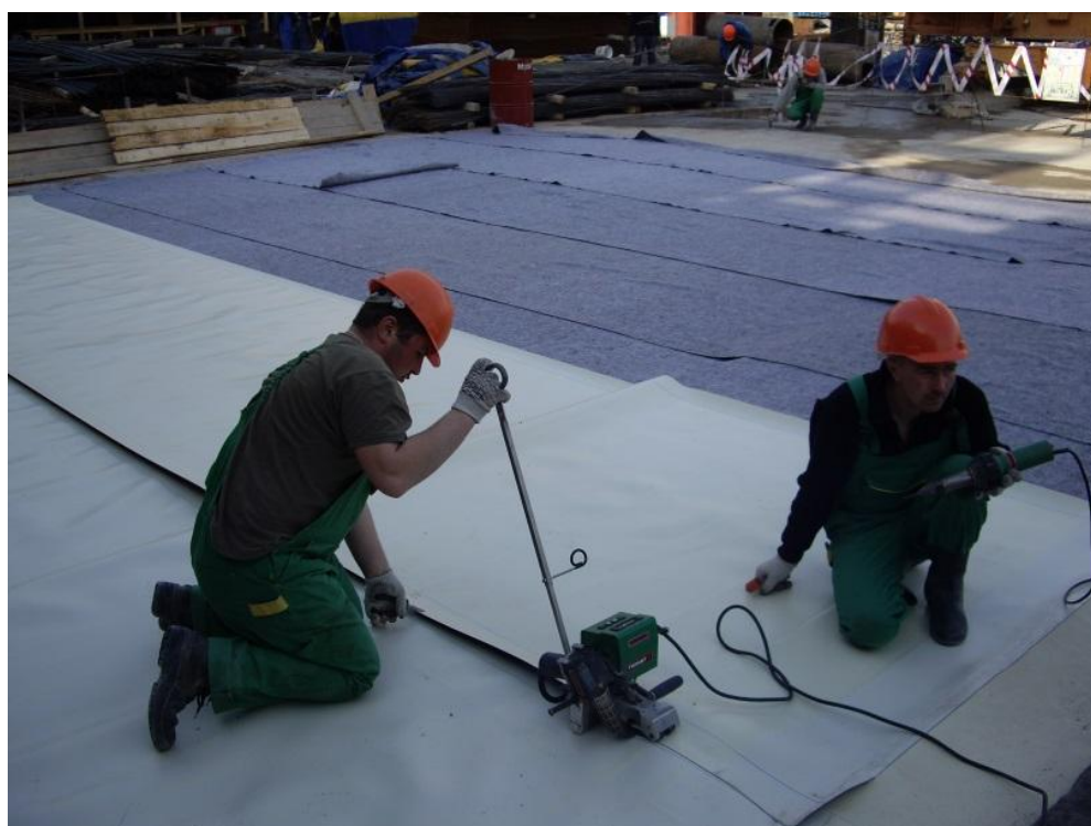
Рисунок 2 - Укладка гидроизоляционной ПВХ – мембраны на горизонтальной части захватками
