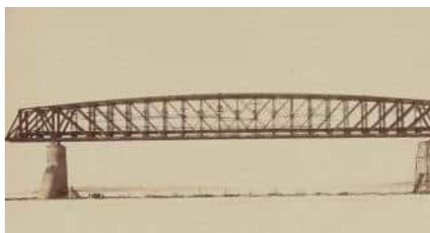
Рисунок 4 – Пролет Обского моста
