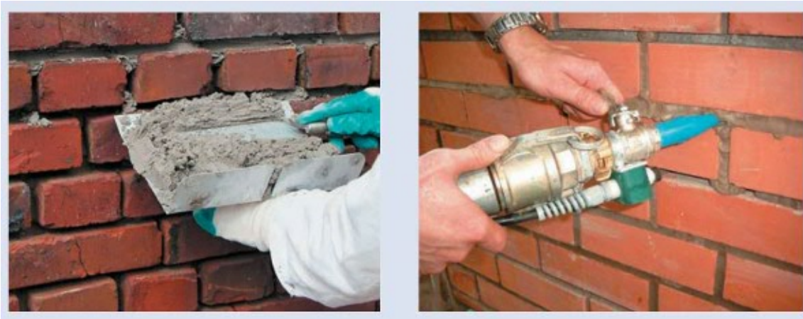
Рисунок 2 - Способы заполнения швов
