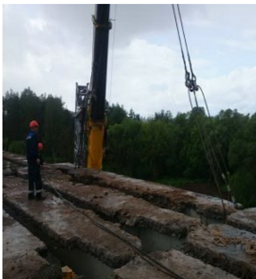
Рисунок 1 – Демонтаж балок пролетного строения
