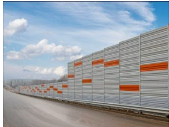
Рисунок 4 - Акустический экран с оцинкованной металлоконструкцией
