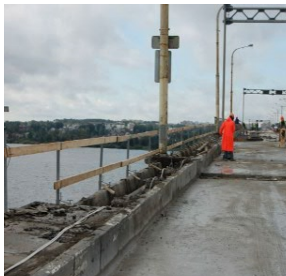
Рисунок 2 – Капитальный ремонт ответственных конструкций
