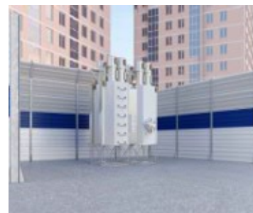
Рисунок 7- Временная защита холодильной установки
