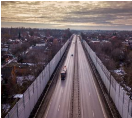
Рисунок 1-Акустический экран с отсутствием сборных соединений
