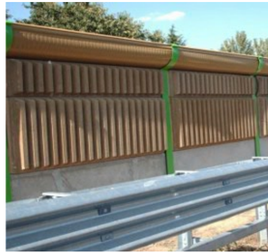
Рисунок 2 -Экран-стенка составной Г-образной формы со звукоизолирующей облицовкой
