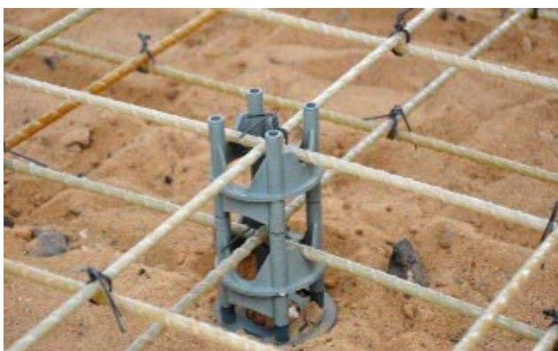
Рисунок 1 - Крепление стеклопластиковой арматуры с помощью хомутов и фиксаторов
