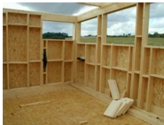
Рисунок 4 - Основой каркаса выступают детали из дерева - обычные доски
