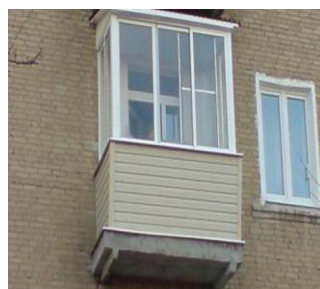
Рисунок 11 – Балкон на консольной железобетонной плите
