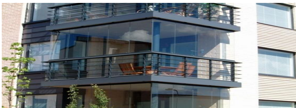
Рисунок 1 – Балкон на консольных балках
