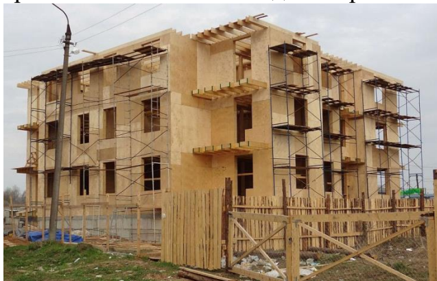
Рисунок 3 - Панельно – деревянная схема возведения
