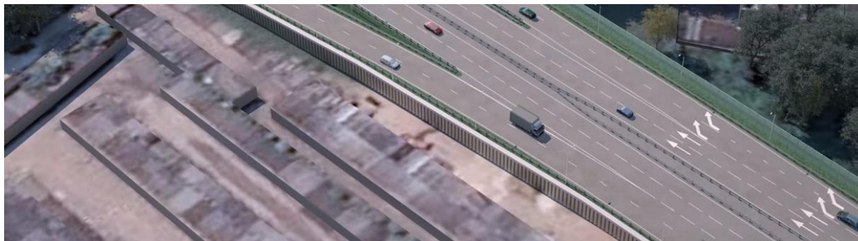
Рисунок 5 - Подпорные стены, удерживающие насыпь автодороги
