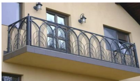
Рисунок 4 - Металлическое ограждение балкона
