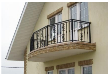
Рисунок 3 – Кованое ограждение балкона
