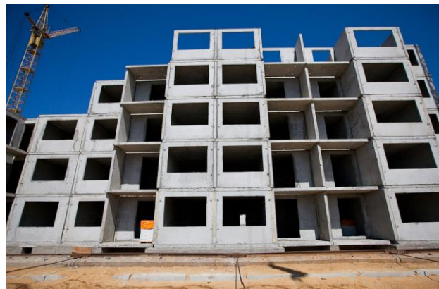
Рисунок 2 – Панельно-каркасная схема возведения
