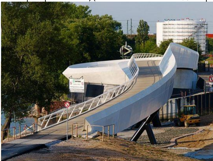
Рисунок 3 - Необычный закрученный мост «Olhafen Bridge»
