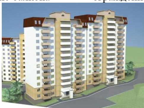
Рисунок 7 – Балконы крупноэлементных зданий
