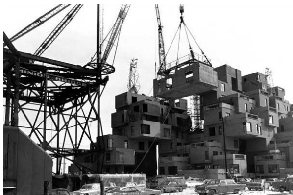
Рисунок 5 – Строительство жилого комплекса Хабитат
