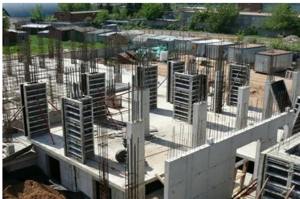
Рисунок 1 - Монолитно-каркасная схема возведения
