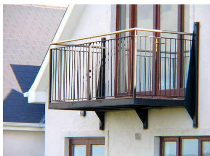
Рисунок 10 – Балкон на консольных балках
