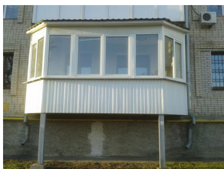
Рисунок 12 – Балкон с внешними опорами
