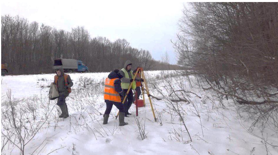
Рисунок 3 - Производим геодезическую разбивочную основу
